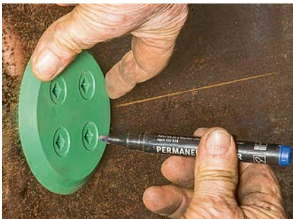
Der Einbau ist einfach: Mit einem Stift zeichnet man die vier Löcher an.
