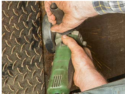
Das Entgraten ist wichtig, damit sich später keine Halme unter der Platte verklemmen.
